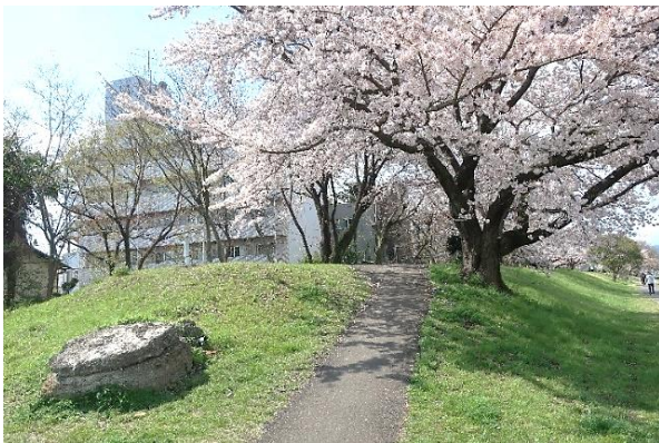
南浅川右岸堤防 途切れています
