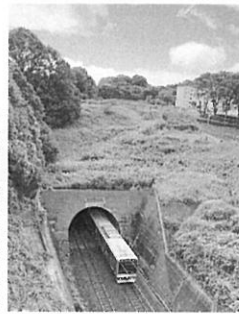
▶ 電車見橋と道路計画跡
